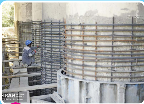
مقاوم‌سازی ۲۴ پل در سطح پایتخت
